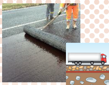
Renforcement de chaussées
