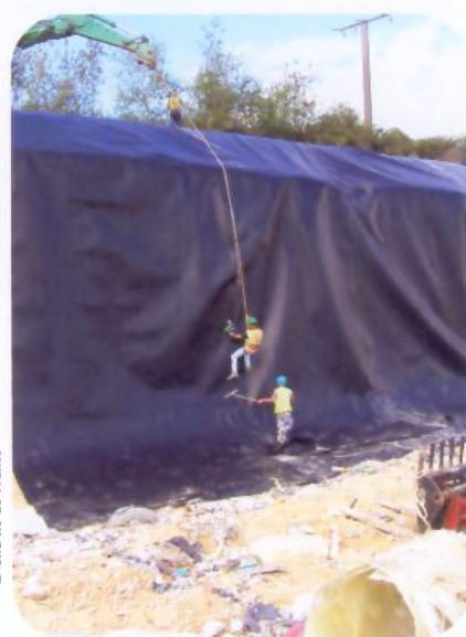
La pose de geomembrane sur paroi verticale a nécessité la mise en œuvre de techniques proches de l'alpinisme.
