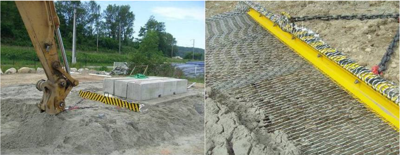
Figure 7. Photos du dispositif d'essai et du portique d'extraction.
