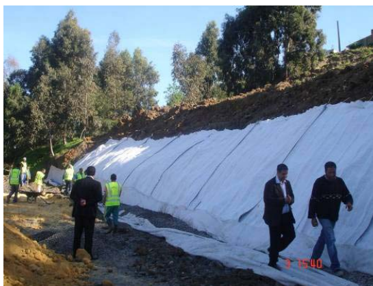
Figure 19 : mise en œuvre du géocomposite de drainage
