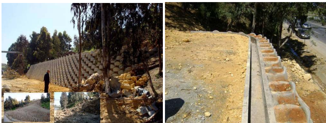
Figures 20 et 21 : ouvrage en phase de construction
