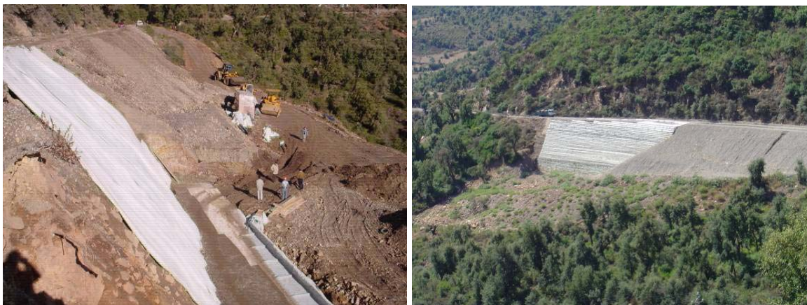
Figures 28 et 29 : vues de l'ouvrage en cours de construction et achevé
