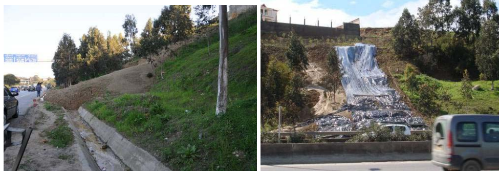
Figures 1 et 2 : vue de la voie rapide et de la coulée de boue.
