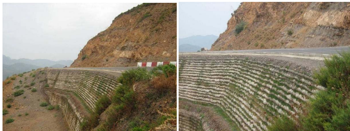
Figures 42 et 43 : vue de l'ouvrage achevé
