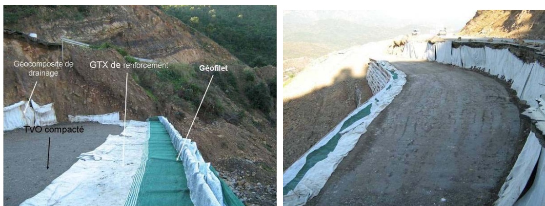
Figures 32 et 33 : vues de l'ouvrage pendant la phase travaux
