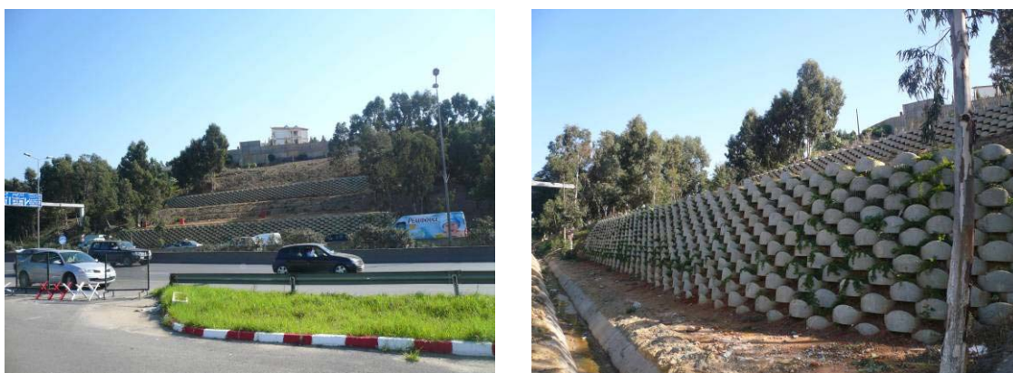
Figures 22 et 23 : ouvrage achevé
