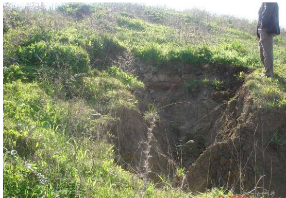
Figure 12: Erosion causée par les eaux de ruissellement en amont du talus
