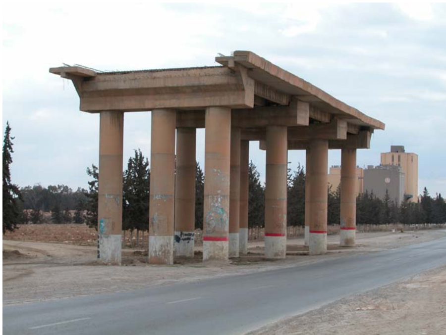
Figure 6 : vues de l'ouvrage, de l'exploitation agricole et des habitations
