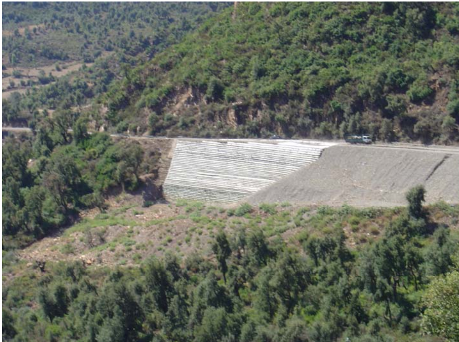
b. Ouvrage achevé
