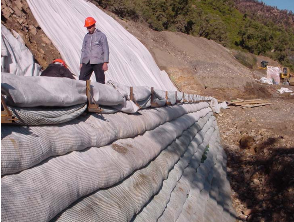
a. Ouvrage en cours de travaux
