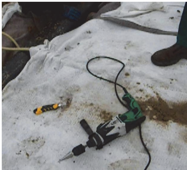
Figure 6. Matériel nécessaire à la pose du connecteur de drainage.
