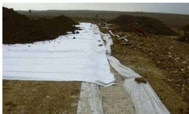
Photo A8 : Raccordement à la tranchée
