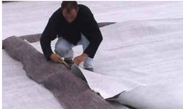
Figure A3 et photo A6 : Traitement des jointes transversaux (bout à bout)
