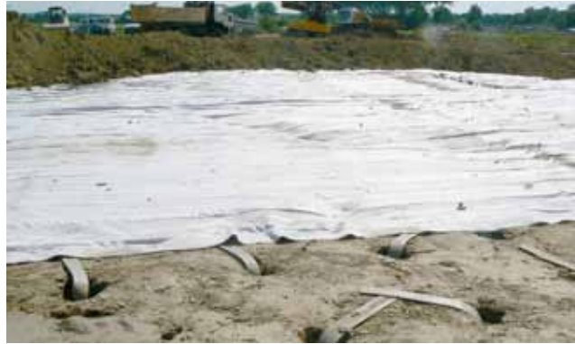
Photos A10 et A11 : connexion hydraulique drains verticaux - géocomposites de la gamme SOMETUBE 850 FTF D20
