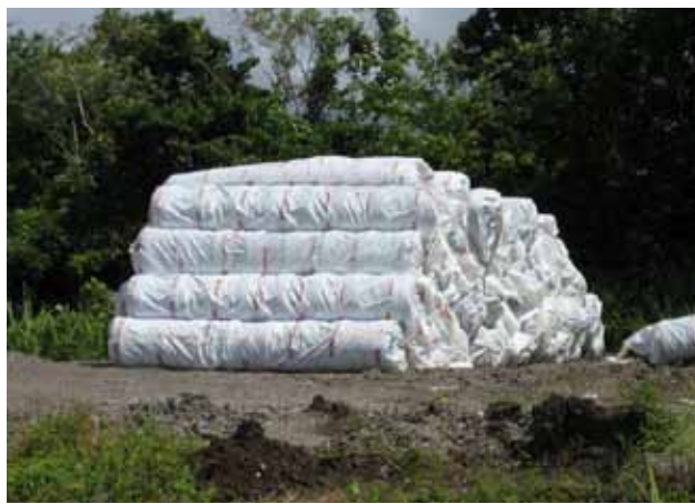
Photo A4 : Stockage des rouleaux des géocomposites de la gamme SOMTUBE 850 FTF D20
