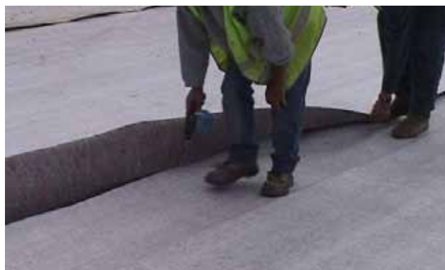
Figure A4 et photo A7 : Traitement des joints longitudinaux (côte à côte)
