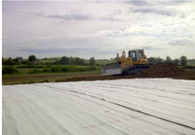
Photo A5 : Mise en œuvre des géocomposites de la gamme SOMTUBE 850 FTF D20
