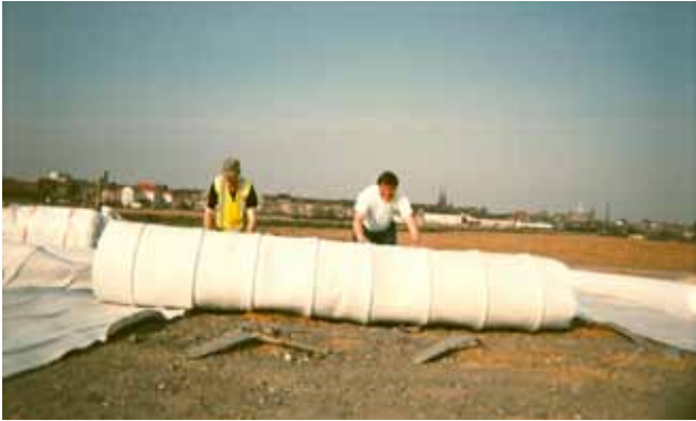
Photos A10 et A11 : connexion hydraulique drains verticaux - géocomposites de la gamme SOMETUBE 850 FTF D20
