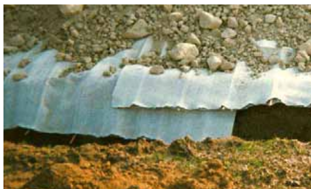
Photo A9 : Raccordement au fossé
