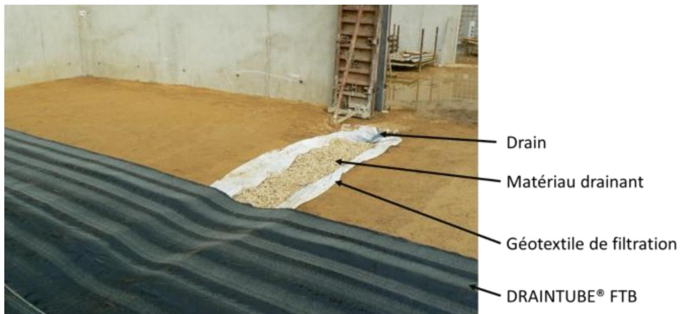
**Figure 2 - Raccordement DRAINTUBE® FTB / tranchée drainante**
