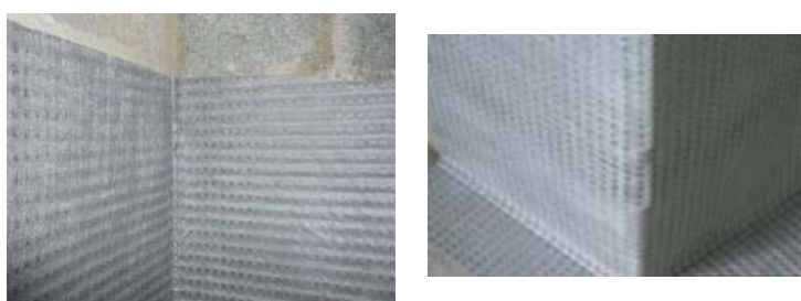
Figure 13 : Pose de l'ALVEODRAIN® F dans les angles rentrants (à gauche) et sortants (à droite)
