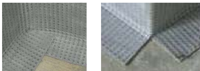
Figure 14 : pose de l'ALVEODRAIN® F dans les angles rentrants (à gauche) et sortants (à droite), en pied d'ouvrage
