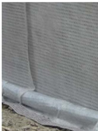
Figure 11 : Débord de filtre pour pose en « tuile » des lés verticaux
