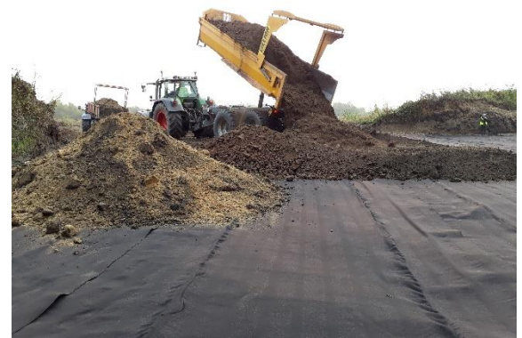
Remblaiement sur le SOMTUBE FTF
