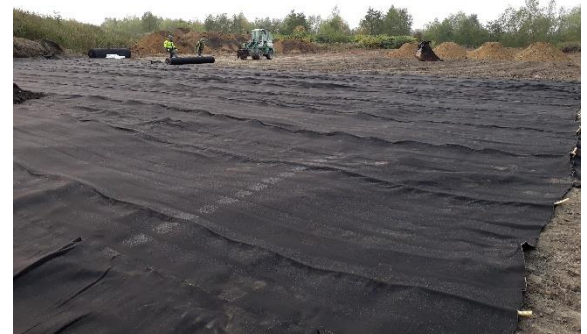
Installation du SOMTUBE FTF sur le sol support
