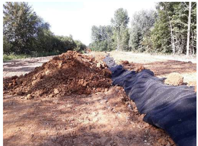
Montée du DRAINATEX à la verticale (pose en « accordéon »)
