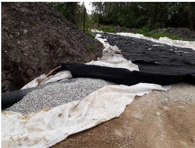
Raccordement à la tranchée collectrice
