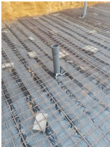
Pose du ferrailage
