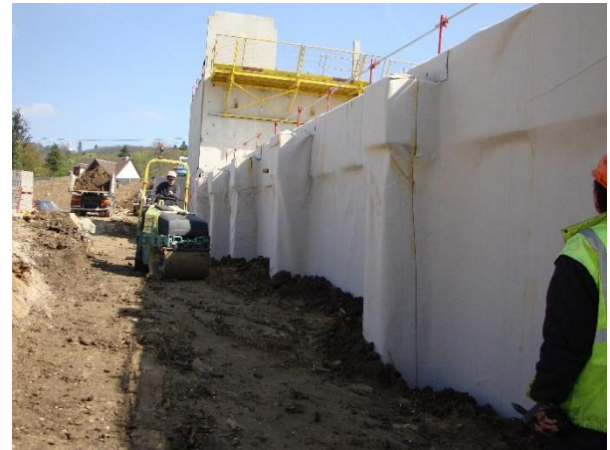
Pose du SOMDRAIN T5 sur l'isolant avec la colle SOMFIX N
