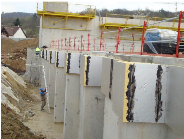
Pose de l'isolant au niveau de la dalle avec la colle bitume ISOL RT5
