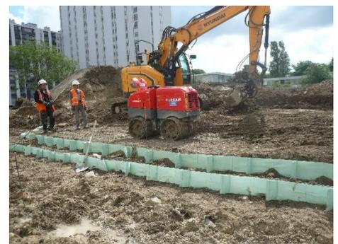
*Déploiement, remblaiement et compactage*
