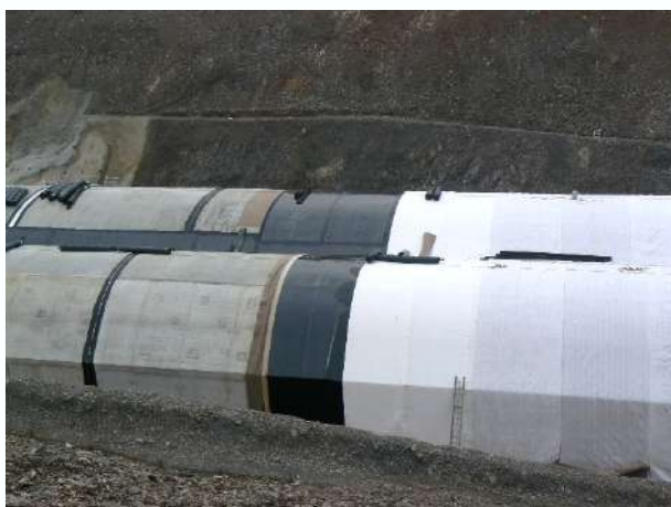
Recouvrement de l'étanchéité par le DRAINTUBE T
