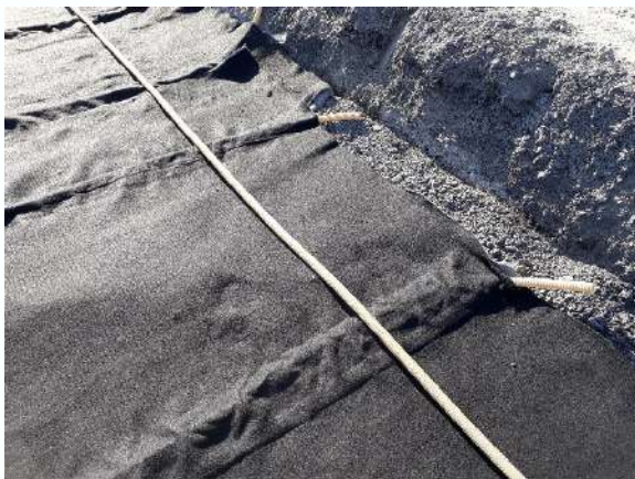
Mise en place du drain \phi 25mm
