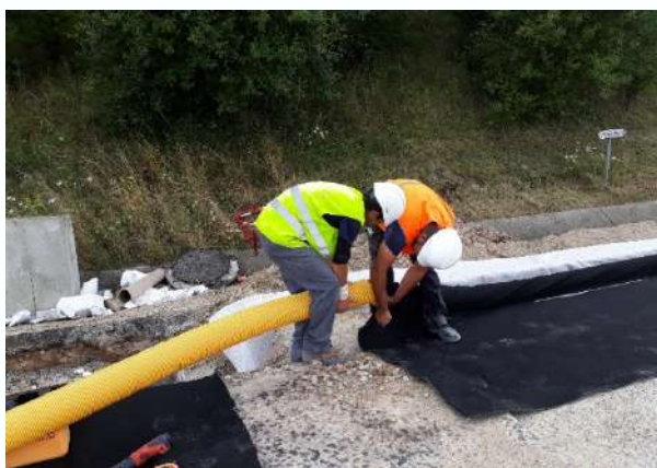
Insertion du drain collecteur dans le manchon
