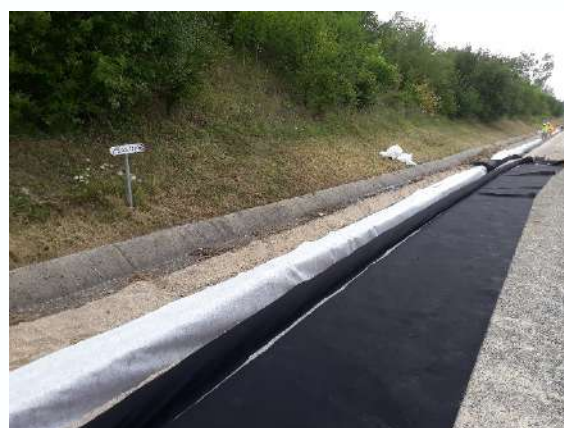
Mise en place du DRAINCOTEX dans la tranchée
