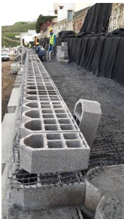
Pose rang par rang des blocs, géo grille et géocomposite de drainage
