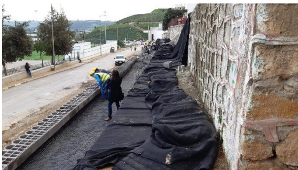
Pose rang par rang des blocs, géo grille et géocomposite de drainage
