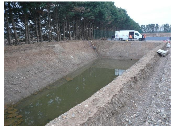
Préparation de la tranchée d'ancrage
