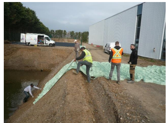
Déploiement des nappes dans le talus
