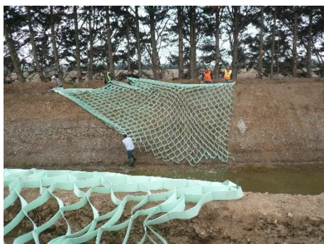
Ajustements et implantation des piquets d'ancrages selon note de calcul
