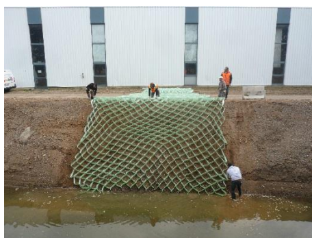
Déploiement dans les talus et tranchées d'ancrages
