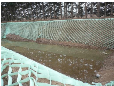
Ajustements et implantation des piquets d'ancrages selon note de calcul
