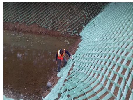
Ajustements et implantation des piquets d'ancrages selon note de calcul
